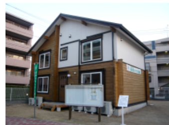
写真 実験棟 (混構造)
